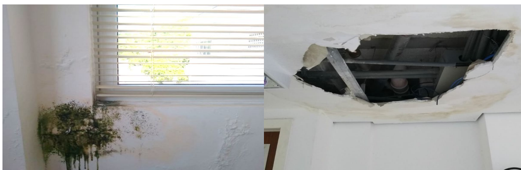
Figura 3 – umidade extremidade janela.
